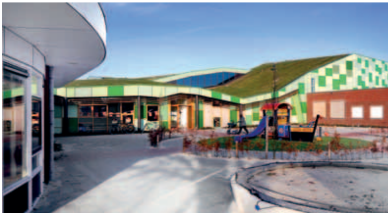
Buitenzijde van gemeenschappelijke gymzaal.
