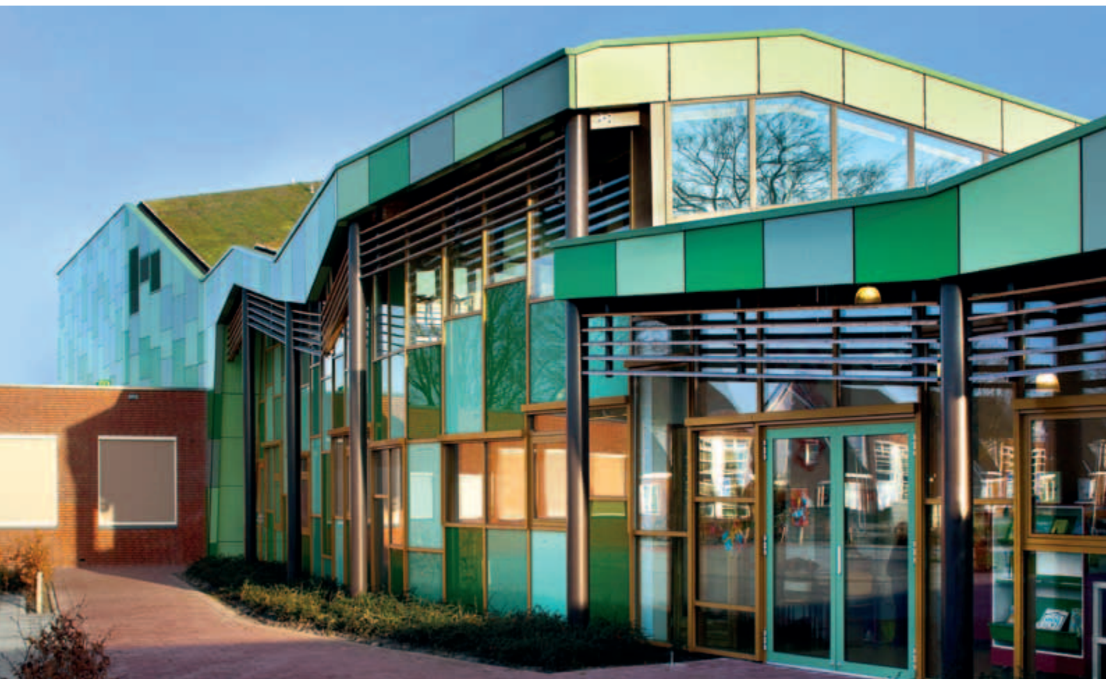
Entree van brede-schoolgebouw De Groenling.
